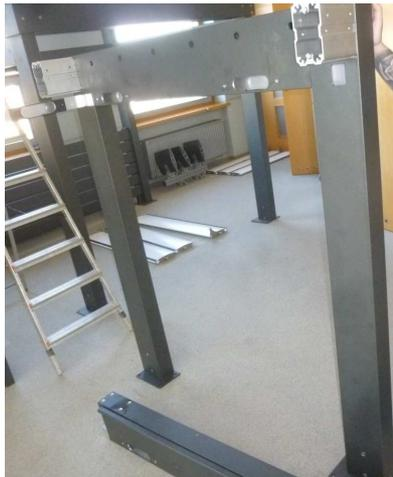
7. Setzen Sie die zweite seitliche Strebe mit den entsprechenden Pfosten analog zu Pkt 5 zusammen. Sichern Sie den zusammengebauten Konstruktionsteil vorm Umstürzen (Zeichn. 6).
