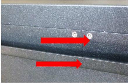
6. Dichten Sie die Verbindungsstelle der Ergänzungslamelle in der Mitte des vorderen Profils ab (Zeichn.18).
